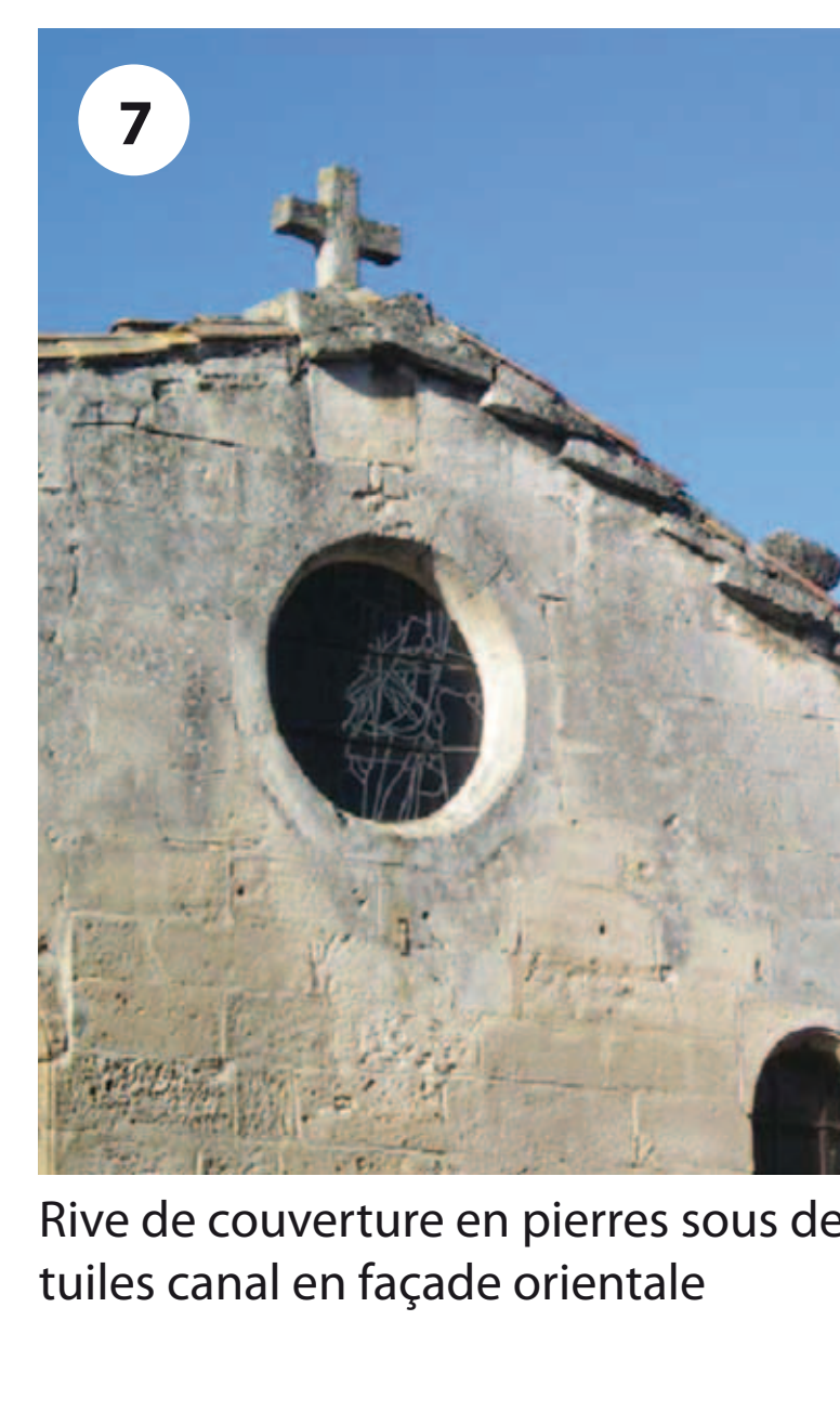
8 Rive de couverture en pierres sous des tuiles canal en façade orientale
