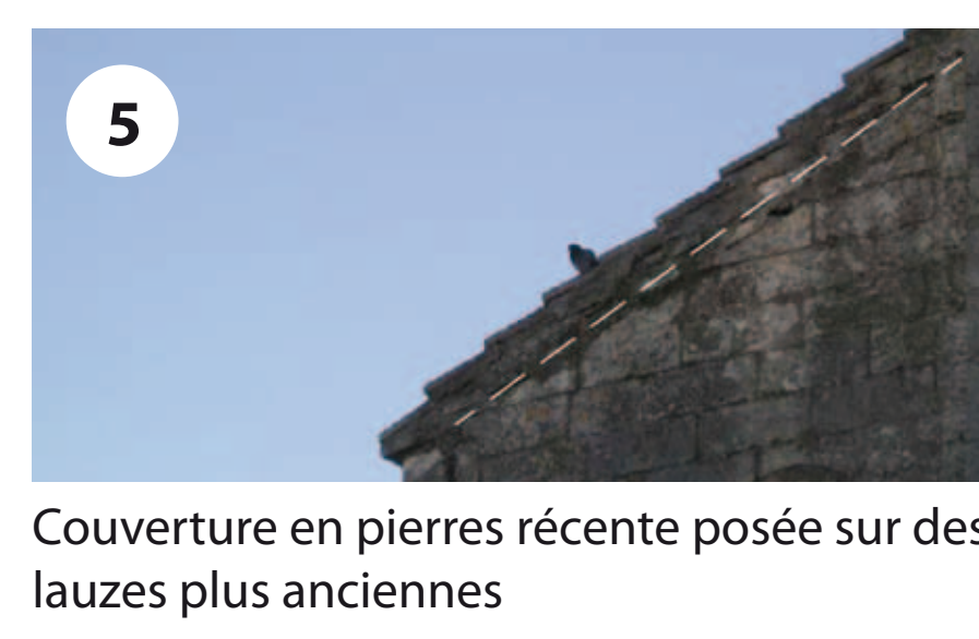
6 Couverture en pierres récente posée sur des lauzes plus anciennes
